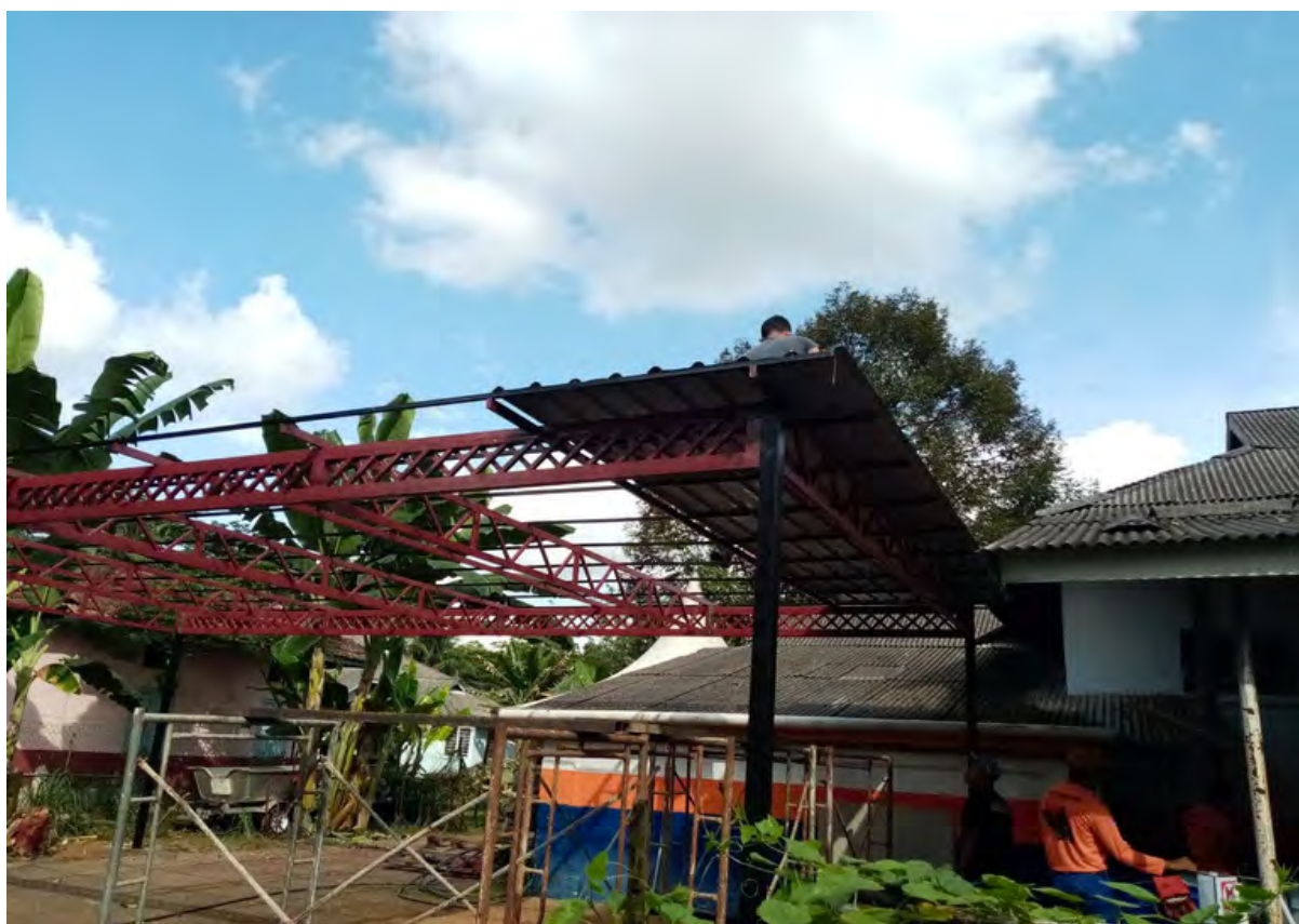
Rajah 14 Proses pemasangan bumbung garaj.
